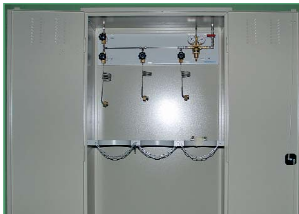
Фото 6. Газо-разрядная рампа на три баллона кислорода или инертного газа с ручным управлением
